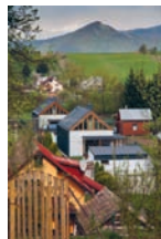
Rodinné domy súrodencov, Konská Konská 463-464 Autor: Peter Kasman Foto: Roman Kanich, Peter Kasman
