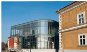
Ostrovy kultúry - otvorená zóna5 - Verejná knižnica J. Bocatia v Košiciach Hviezdoslavova ul., Košice Autori: Ladislav Bobčák, Ján Piliarkin Foto: Juraj Gašpar
