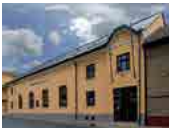
REKONŠTRUKCIA ROBOTNÍCKEHO DOMU Robotnícka 3, Banská Bystrica Autori: Ladislav Bradiak, Roman Jariabka Foto: Ján Pavúr
