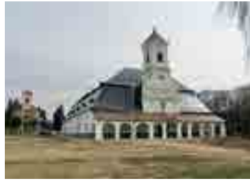
NKP – SOLIVAR PREŠOV REKONŠTRUKCIA OBJEKTU SKLADU SOLI Námestie osloboditeľ'ov 4, Prešov Autori: Ján Katuščák, Jozef Polák Foto: Ján Katuščák, Jozef Polák
