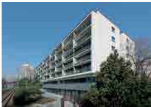
MILETIČOVA 5, REKONŠTRUKCIA POLYFUNKČNEJ BUDOVY Miletičova 99/5, Bratislava-Ružinov Autori: Juraj Benetin, Roman Čambál, Miroslav Čatloš, Juraj Česelský, Matej Grébert, Juraj Kurpaš Foto: Pavel Meluš
