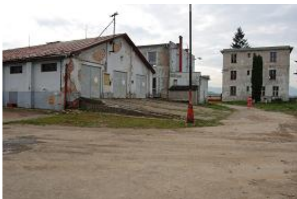
Pohľad na objekt 5 – pôvodnú administratívnu budovu
