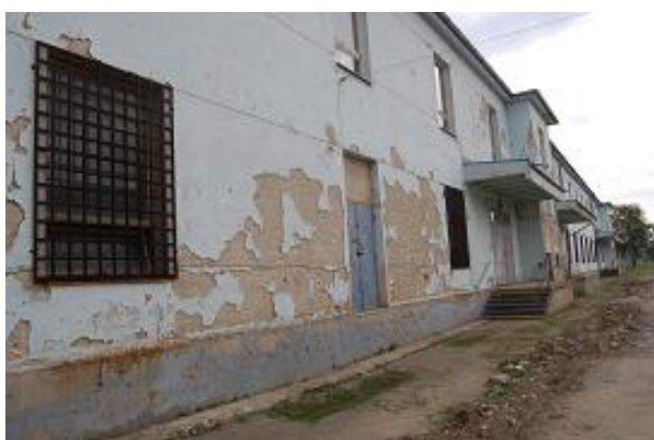
Pohľad na objekt 10 od vstupu z juhozápadu
