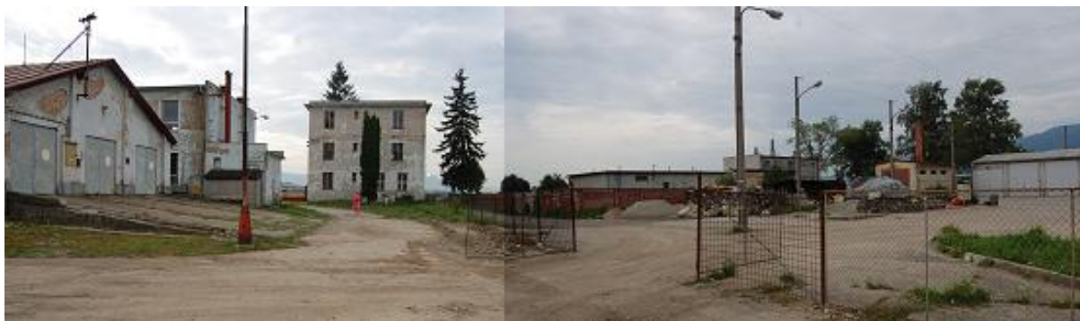
Pohľad na vstupnú časť s 3-podlažnou administratívnou budovou štábu
