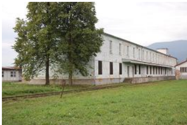
Pohľad na objekt 10 od vlečky z východu
