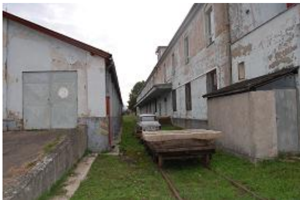
Pohľad na objekt 10 od vlečky zo západu
