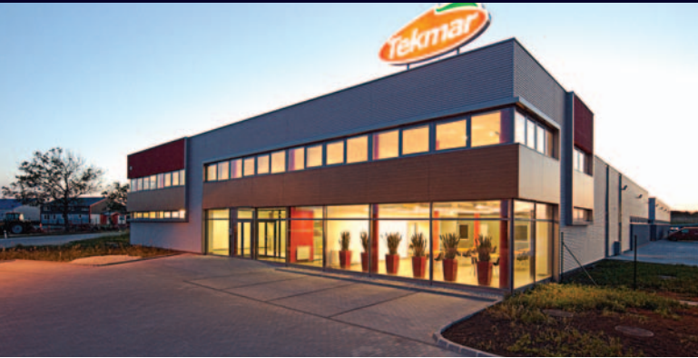
VÝROBNO-SKLADOVÝ AREÁL TEKMAR SLOVENSKO, NITRA MANUFACTURE AND STOREHOUSE AREA TEKMAR SLOVENSKO IN NITRA AUTOR | AUTHOR: MILAN CSANDA
